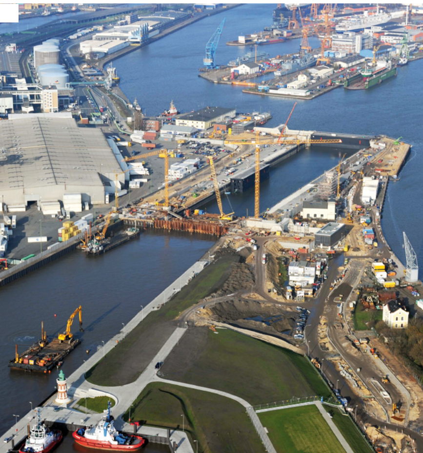
Bau der Kaiserschleuse in Bremerhaven
