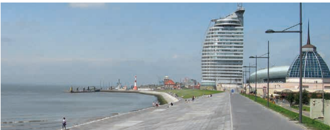
Weserdeich in Bremerhaven, im Zuge des Küstenschutzes wurde der Deichabschnitt um bis zu zwei Meter erhöht
