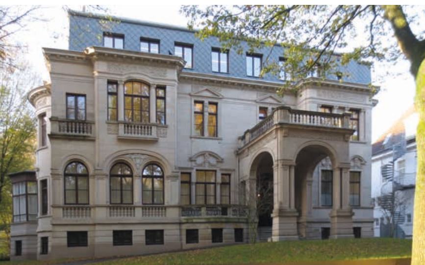
Das Ständesamt Bremen-Mitte nach umfangreicher Sanierung
