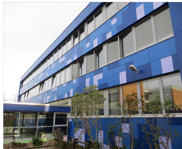
Abbildung 11: Energieeinsparung nach der abgeschlossenen Sanierung im Schulzentrum Utbremen
