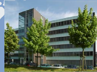
Rostock Data Center Steuern 81 MA
