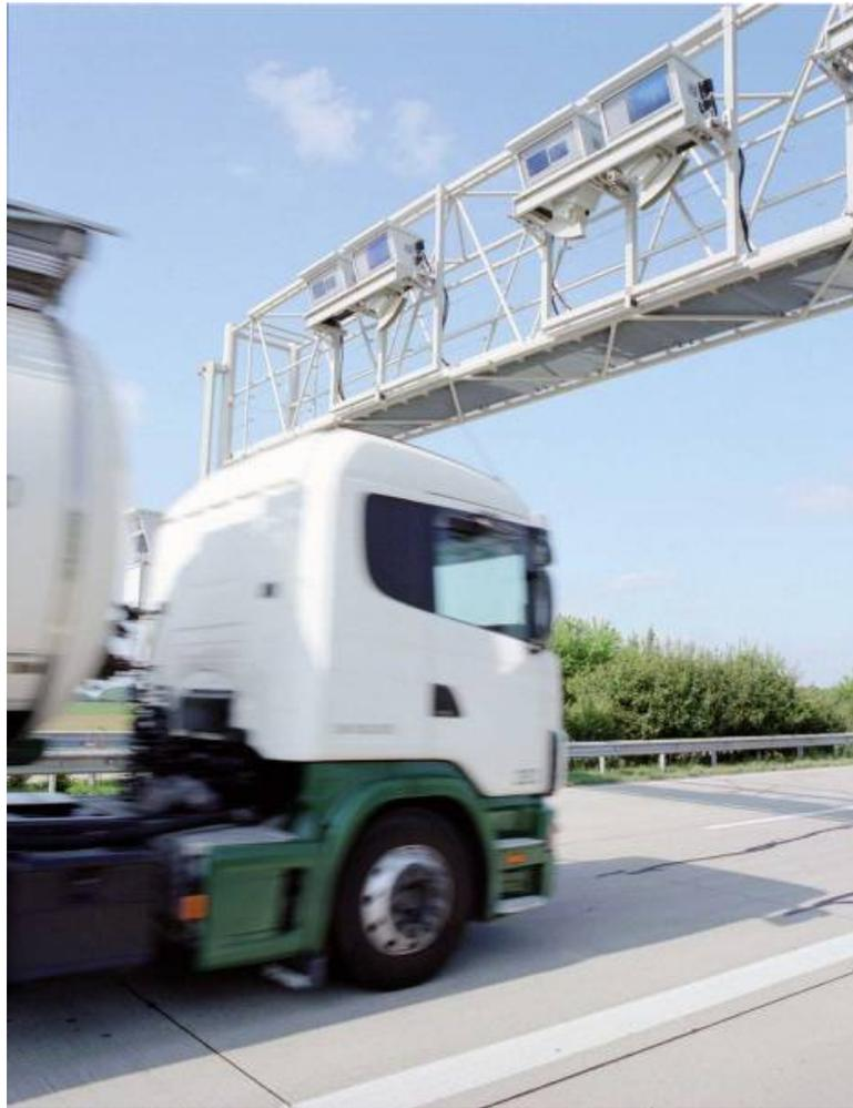
**Abbildung 37: Multi-Lane: Kontrollbrücke im deutschen Lkw-Mautsystem**
